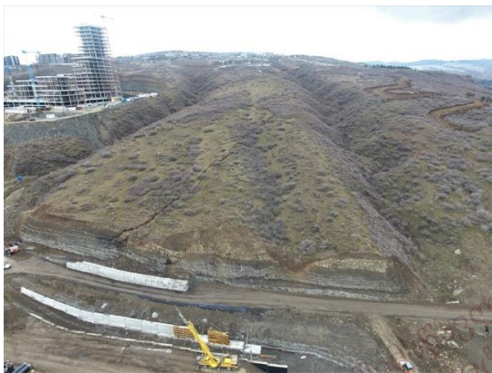
სურათი 2: მაჭავარიანის ქუჩაზე საგზაო და წყალსადენის მშენებლობის დროს განვითარებული ბლოკური მეწყერი
