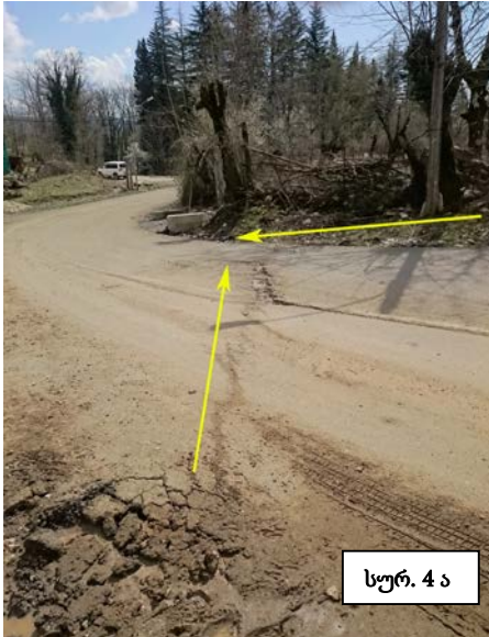
სურ. 4. ასფალტოვანი საფარი დახეთქილია (სურ. 2 ა) და ნაპრალი ვრცელდება მიმდებარე საცხოვრებელი სახლის ეზოში (სურ. 2 ბ).
