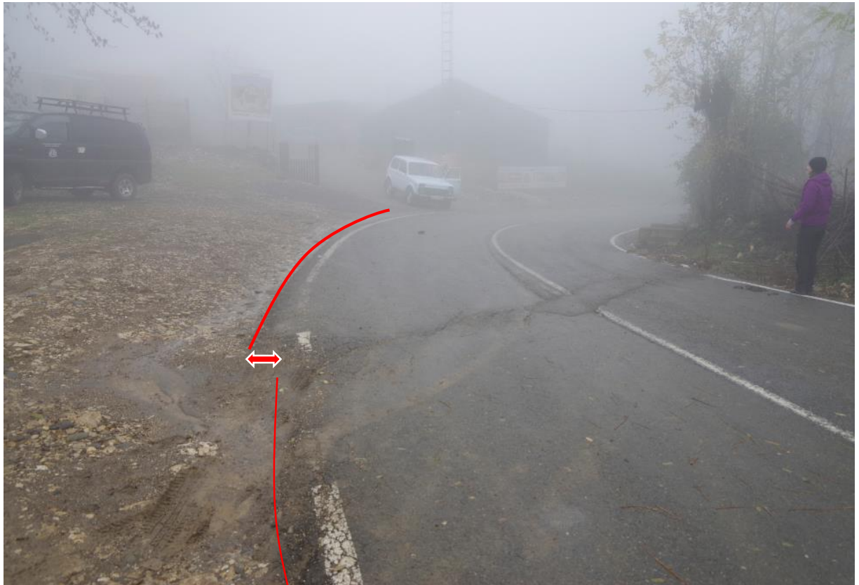
სურ. 3 სოფ. გორდის ცენტრალური გზა. ასფალტის საფარი დანაპრალიანებულია მეწყრის მოპრაობის შედეგად. ნაპრალის მიმართების აზიმუტი - 320^{\circ} - 140^{\circ} .
