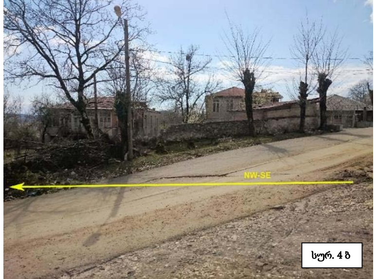
სურ. 4. ასფალტოვანი საფარი დახეთქილია (სურ. 2 ა) და ნაპრალი ვრცელდება მიმდებარე საცხოვრებელი სახლის ეზოში (სურ. 2 ბ).
